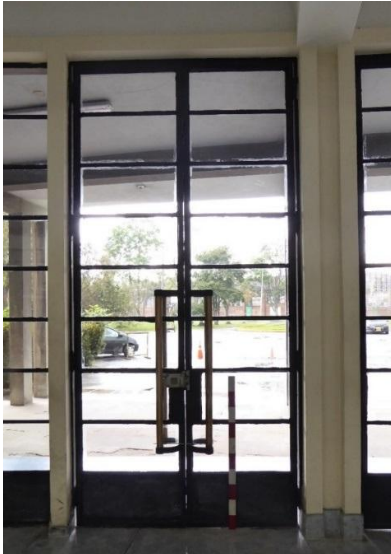
Ilustración 92. Vistas del estado actual. Fotografías CNM.
