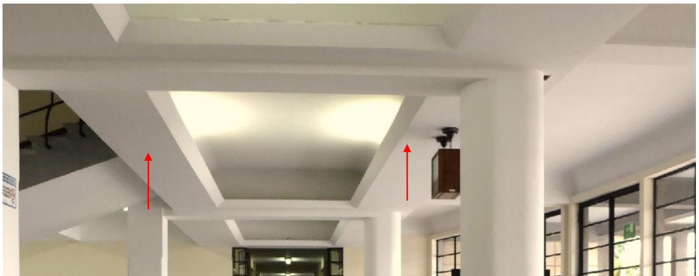
Ilustración 90. Vistas del estado actual. Fotografía CN.
