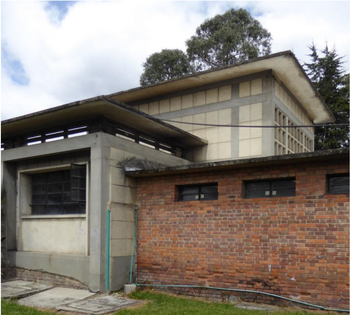
Ilustración 39. Estado actual. Foto: CNM.
