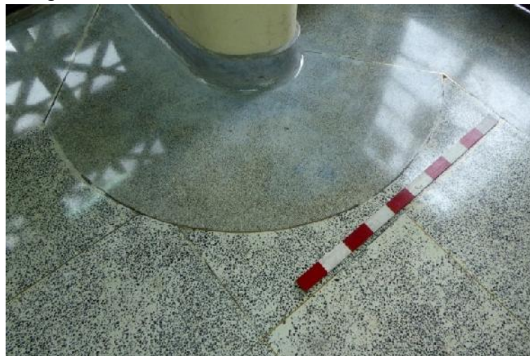
Ilustración 87. Vistas del estado actual. Fotografía CNM.
