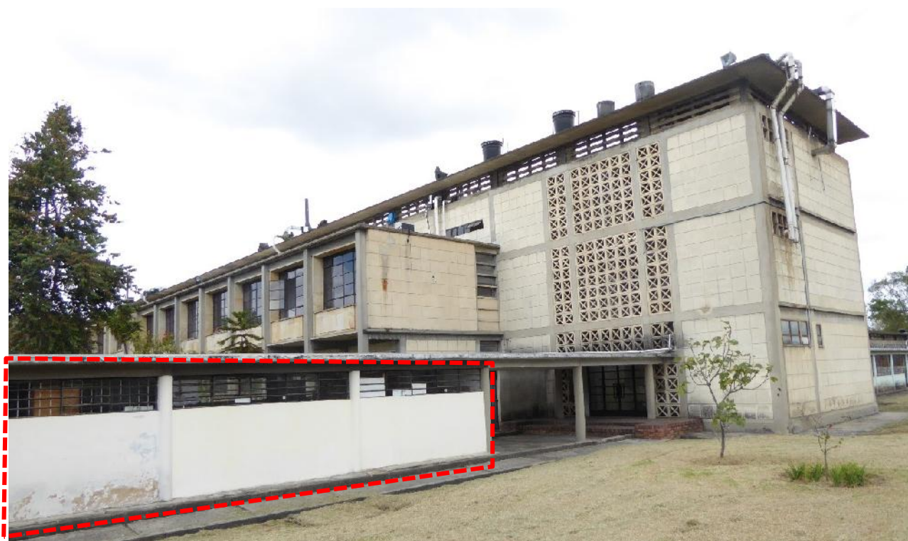
Ilustración 73. Cerramiento de las pérgolas. Foto: CNM
