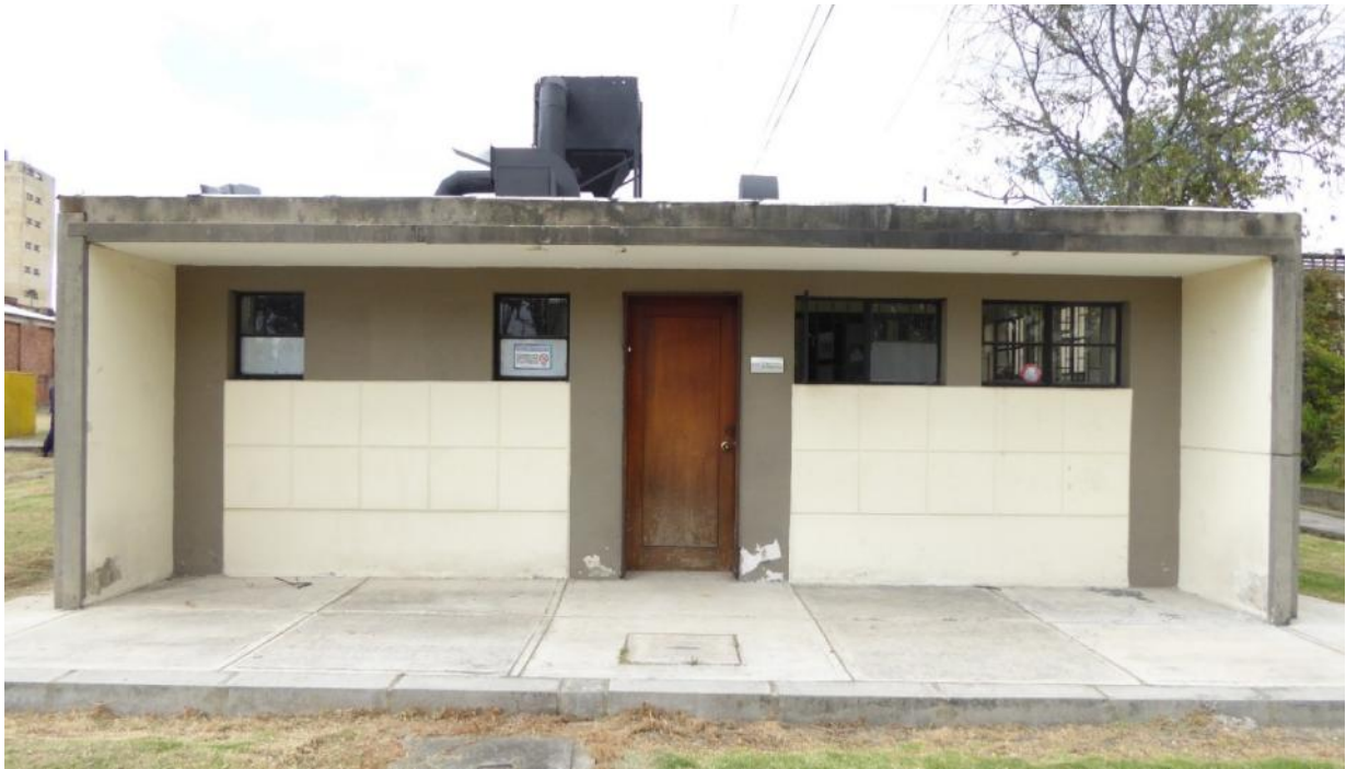
Ilustración 44. Fachada norte. Foto: CNM
