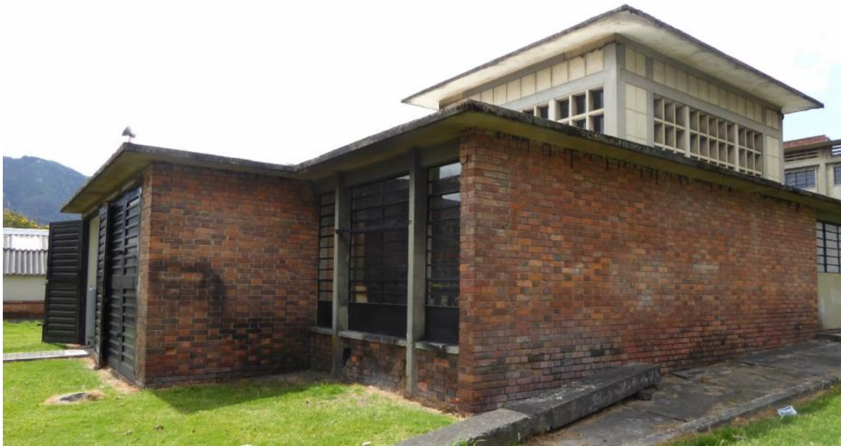
Ilustración 40. Instalaciones en la actualidad. Foto: CNM.
