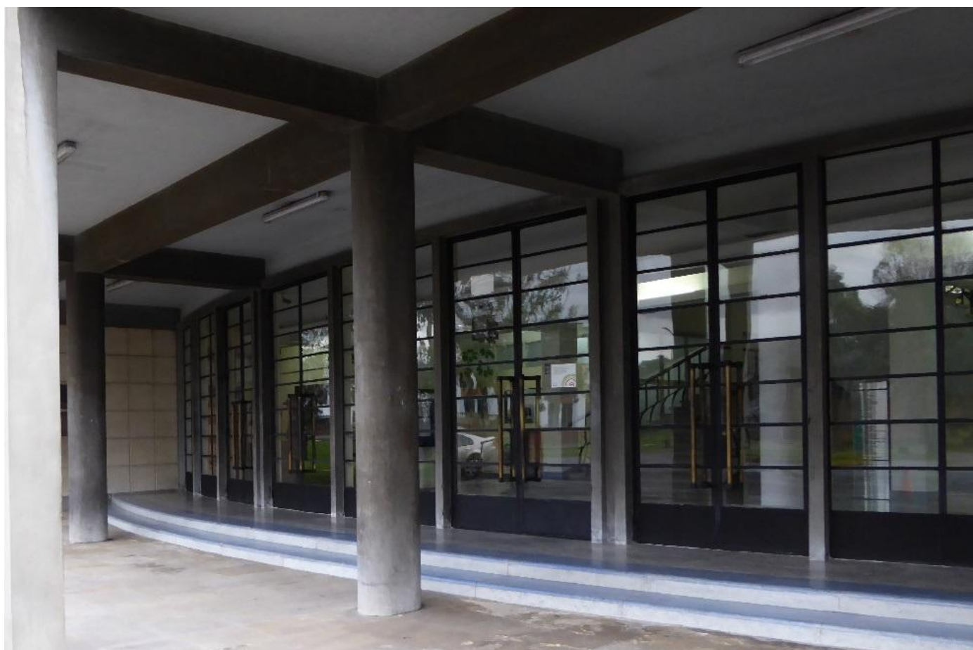
Ilustración 91. Vistas del estado actual. Fotografías TCB.
