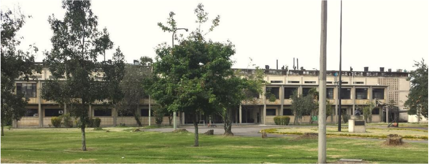
Ilustración 69. Fachada sur del bloque principal. Foto: CNM
