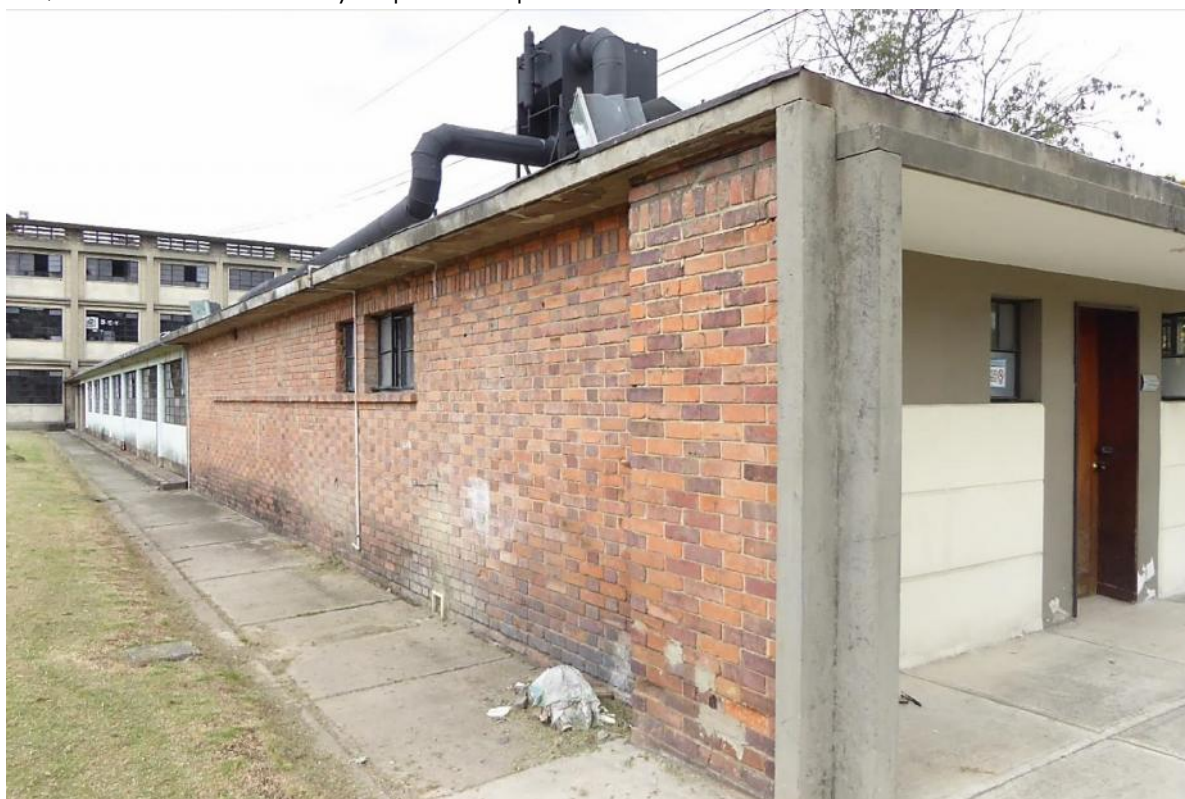
Ilustración 43. Estado actual. Foto: CNM
