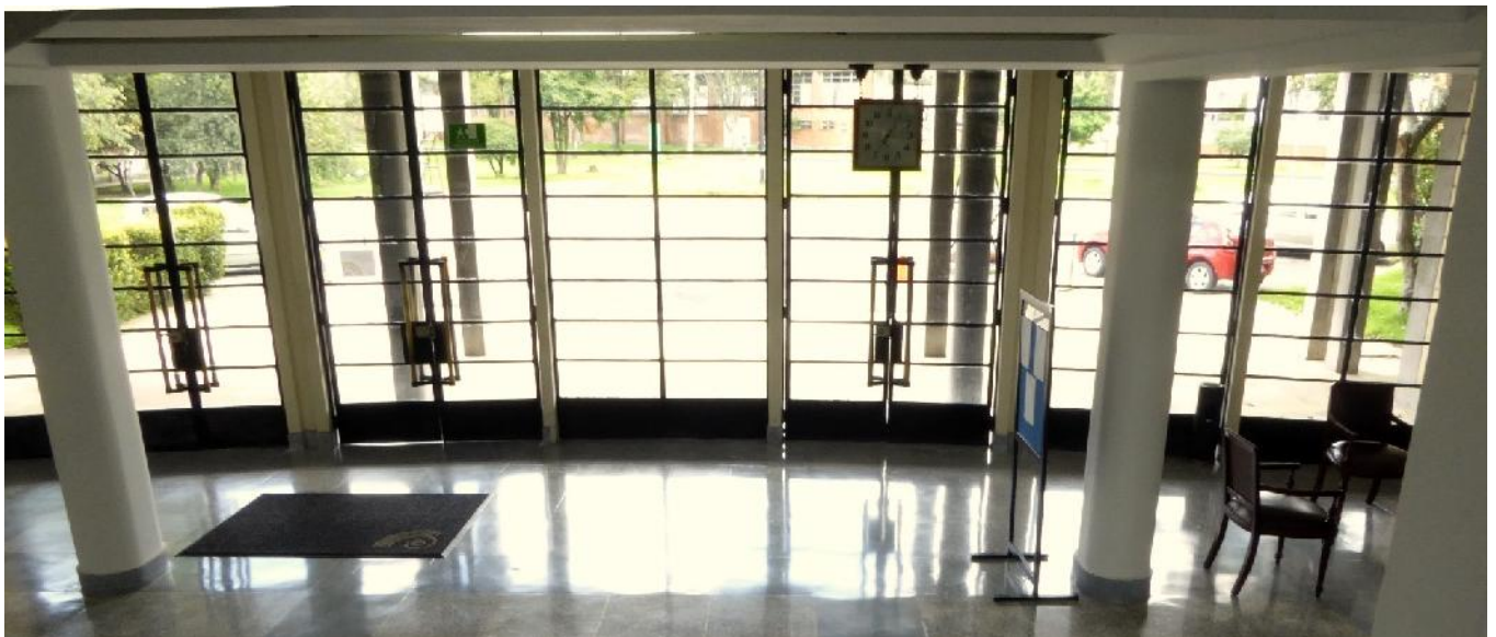
Ilustración 78. Estado actual. Foto: CNM
