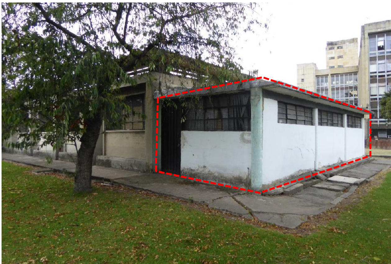
Ilustración 74. Cerramiento de las pérgolas. Foto: CNM
