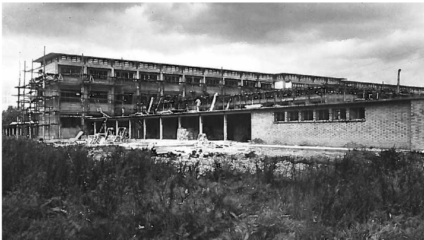
Ilustración 35. Foto antigua del proceso constructivo del edificio. Fuente: Investigación del proyecto.
