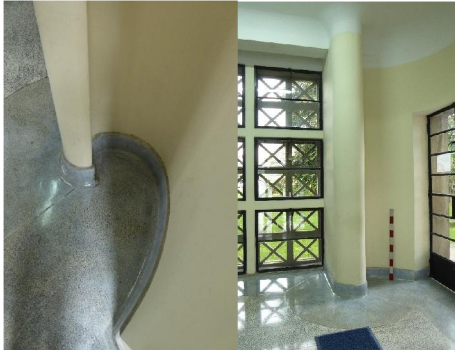
Ilustración 86. Vistas del estado actual. Fotografías CNM.
